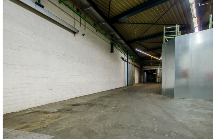
Zuwegung innerhalb des Gebäudes
